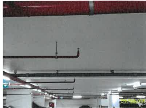
ระบบหัวกระจายน้ำดับเพลิงชั้นจอดรถ
