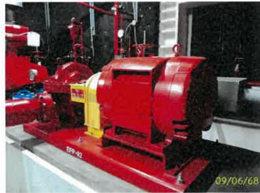
เครื่องสูบน้ำดับเพลิงชั้น 42M สตาร์ทด้วยไฟฟ้า
