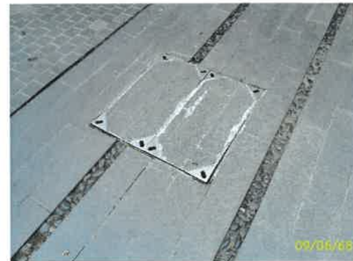
บ่อรับน้ำฝน ระบบระบายน้ำฝนภายนอกอาคาร ภาพที่ 1.3.6-1 (ต่อ) การระบายน้ำของโครงการ
