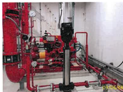
เครื่องสูบน้ำดับเพลิงชั้นใต้ดิน สตาร์ทด้วยน้ำมันดีเซล
