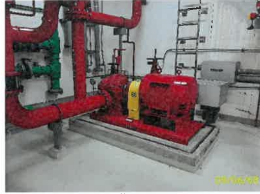
เครื่องสูบน้ำดับเพลิงชั้นใต้ดิน สตาร์ทด้วยไฟฟ้า
