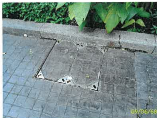
บ่อรับน้ำฝน ระบบระบายน้ำฝนภายนอกอาคาร ภาพที่ 1.3.6-1 (ต่อ) การระบายน้ำของโครงการ
