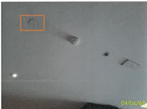
หัวกระจายน้ำดับเพลิงทางเดินห้องพักอาศัย
