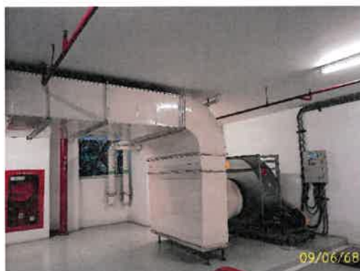
ระบบระบายอากาศชั้นที่จอดรถ
