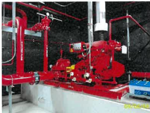
เครื่องสูบน้ำดับเพลิงชั้น 42M สตาร์ทด้วยน้ำมันดีเซล
