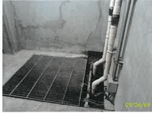
บ่อน้ำ และตู้ควบคุม ชั้นใต้ดิน ระบบระบายน้ำภายในอาคาร (ต่อ)
